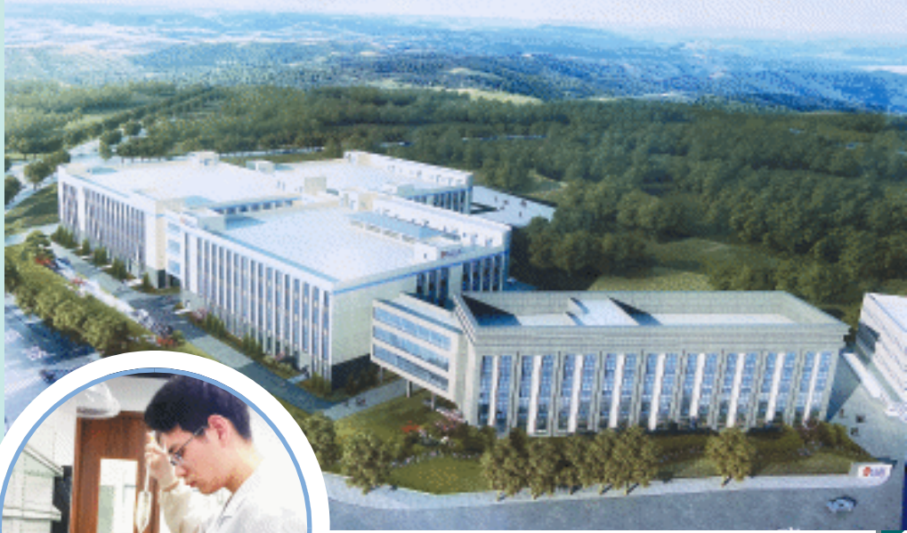
↑长沙新林制药药食同源产业化项目效果图 ←浏阳经开区集聚了一大批中药生产头部企业。图为天地恒一制药股份有限公司工作人员正在做实验。长沙晚报全媒体记者 周斌 摄
