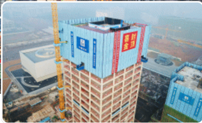
1月11日,世界计算·长沙智谷项目E12地块首栋单体顺利封顶。长沙晚报全媒体记者 陈焕明 通讯员 王雪 摄影报道
