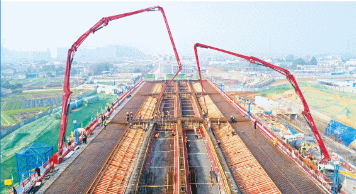
1月11日,湘府东路(浏阳河—黄兴大道)建设工程首联现浇箱梁正在进行浇筑。长沙晚报全媒体记者 王志伟 摄
