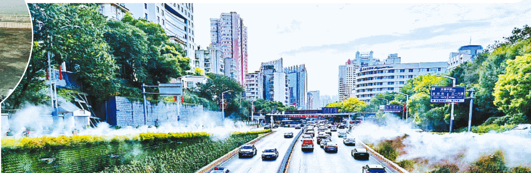
→开福区率先建设重点区域、路段和隧道口喷淋系统,车水马龙中有效抑制扬尘。余果 供图
