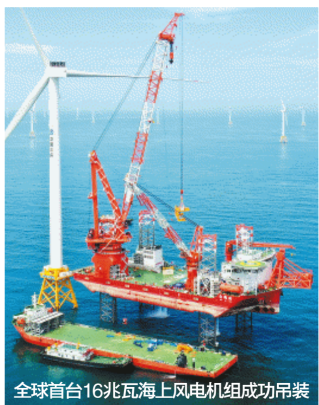
全球首台16兆瓦海上风电机组成功吊装
