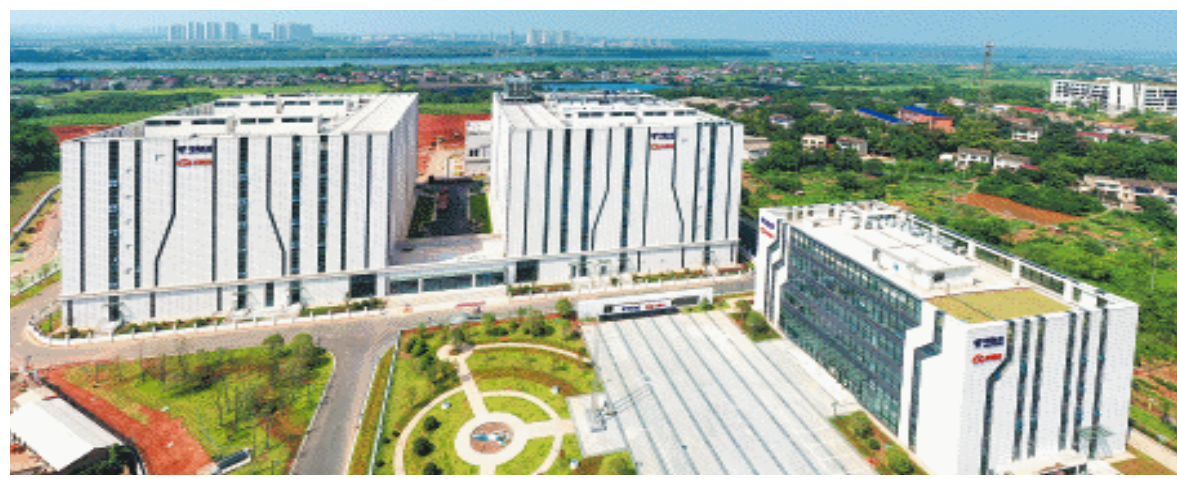
中国电信中南智能算力中心,五栋美观大气的建筑拔地而起,白色外墙上点缀着线条形的玻璃窗,整体看上去,仿佛一个个布满数据流的科技产品。 陈飞摄
