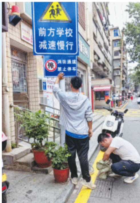
工作人员对学校周边相关路段增设消防通道侧禁停标线、路面警示标志。长沙晚报通讯员 宋进源 供图
