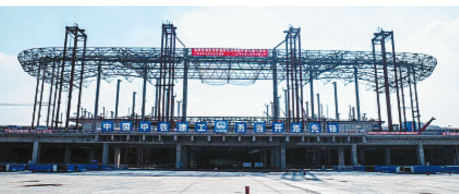
屋盖桁架整体重量超700吨，投影面积超6000平方米。广铁集团供图
