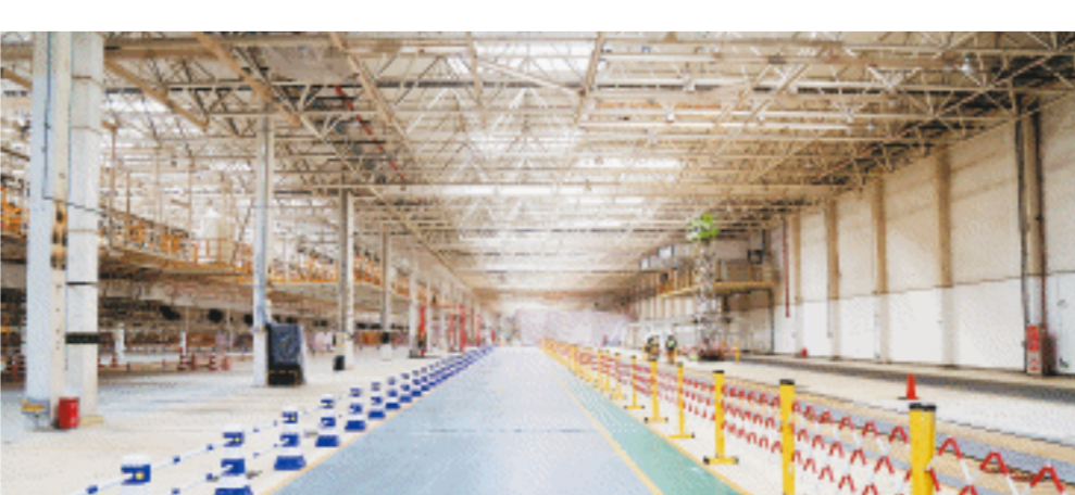
广汽埃安新能源汽车项目正在进行改造施工,预计明年6月量产。长沙晚报通讯员 舒展 摄
