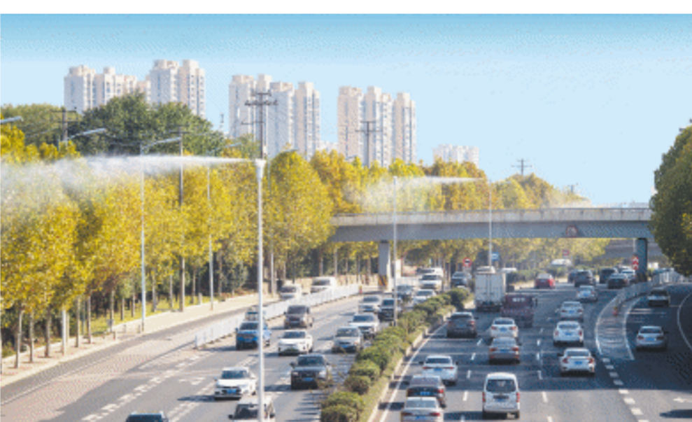
在开福区北二环路,路面上布置的喷淋降尘系统正在进行喷雾降尘。长沙晚报全媒体记者 黄启晴 摄
