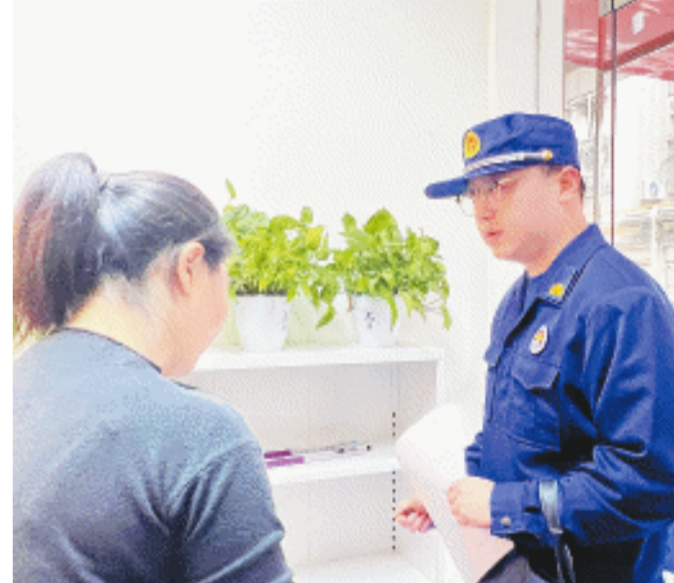
督查人员指出机构在消防设施配备上的不足,并现场演示灭火器的正确使用办法。长沙晚报全媒体记者 周辉霞 摄
