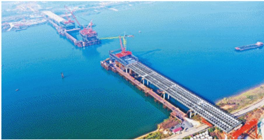
11月27日,暮坪湘江特大桥东岸涉水引桥钢槽梁顶推施工圆满完成,标志着项目东西两岸涉水引桥全部顶推完成。长沙晚报全媒体记者 王志伟 摄
