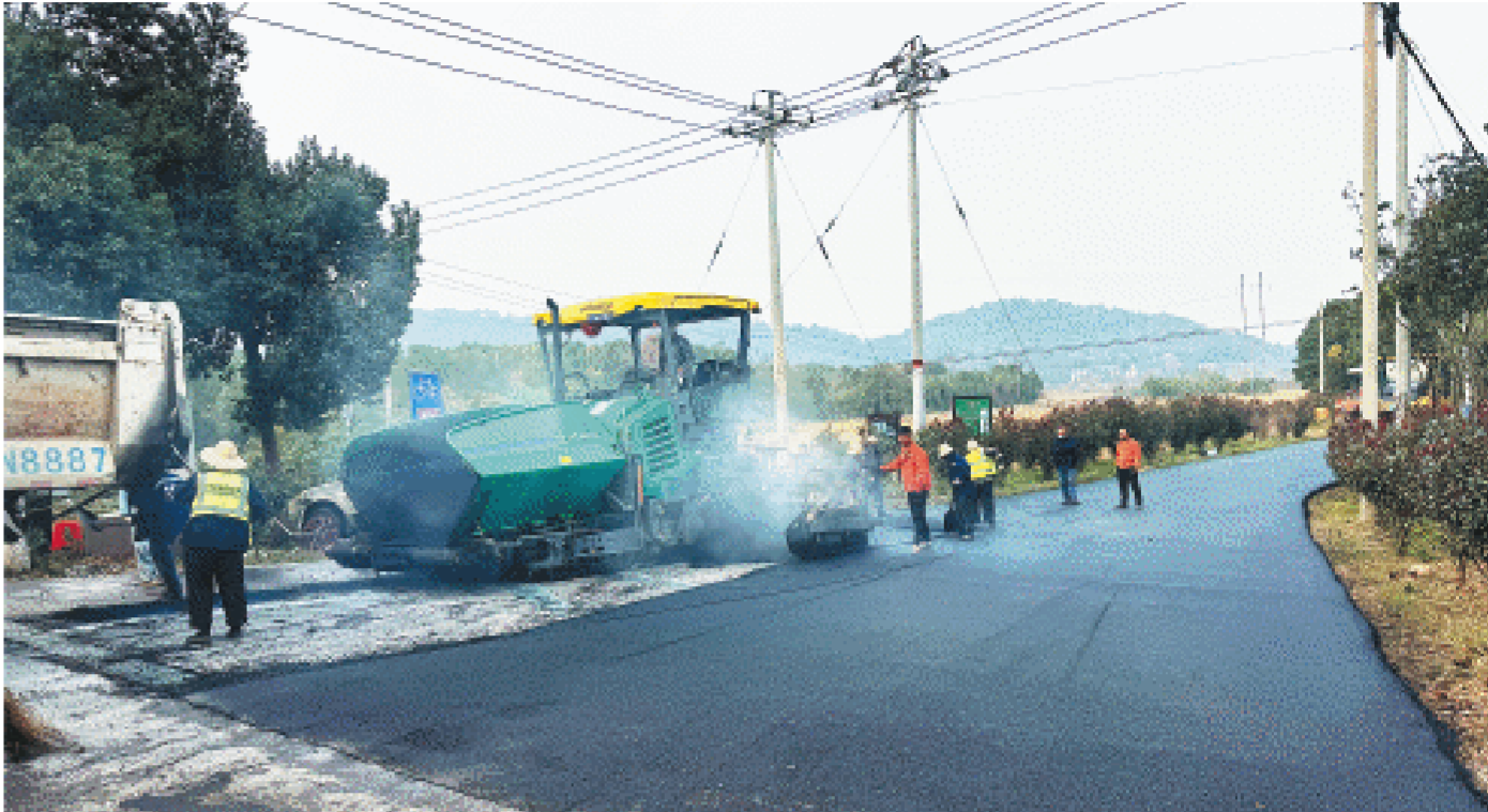
天马大道“白改黑”项目施工现场,党员干部和群众纷纷出力。长沙晚报全媒体记者张禹摄
