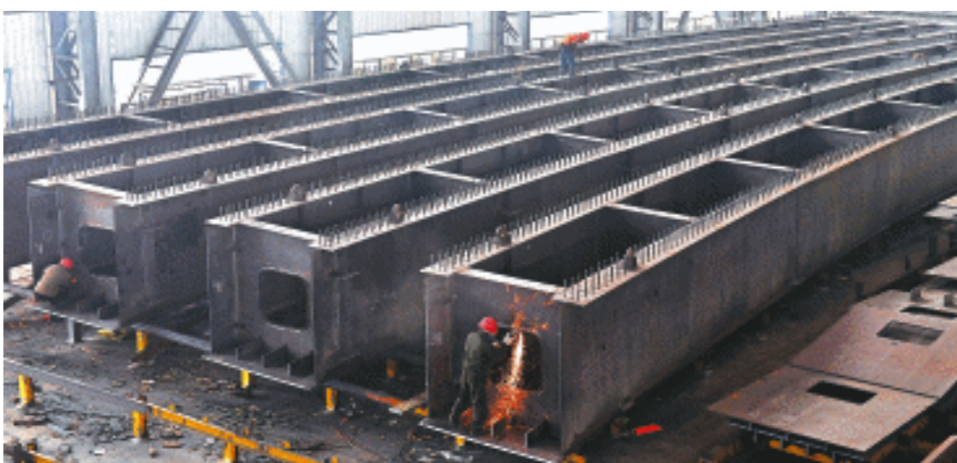
长交集团湘船重工钢结构生产车间内, 火花飞溅、弧光闪烁, 技术工人正在精心处理一批兴联路大通道项目的钢结构部件。长沙晚报全媒体记者 王志伟 摄
