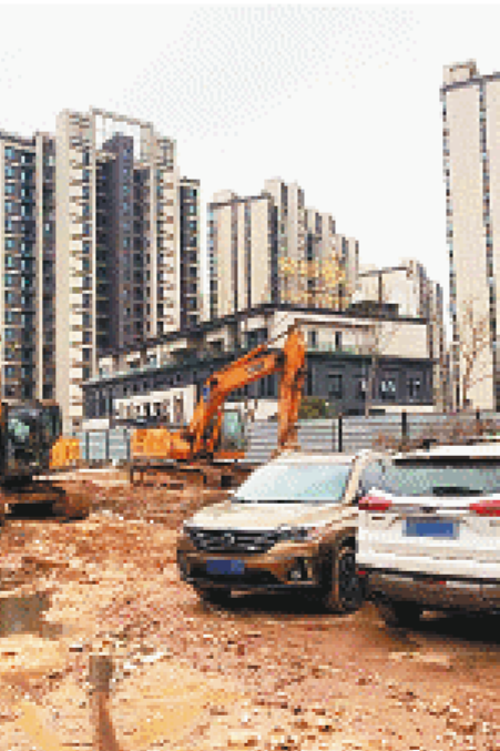
围挡内停了儿辆挖掘机和小车。
