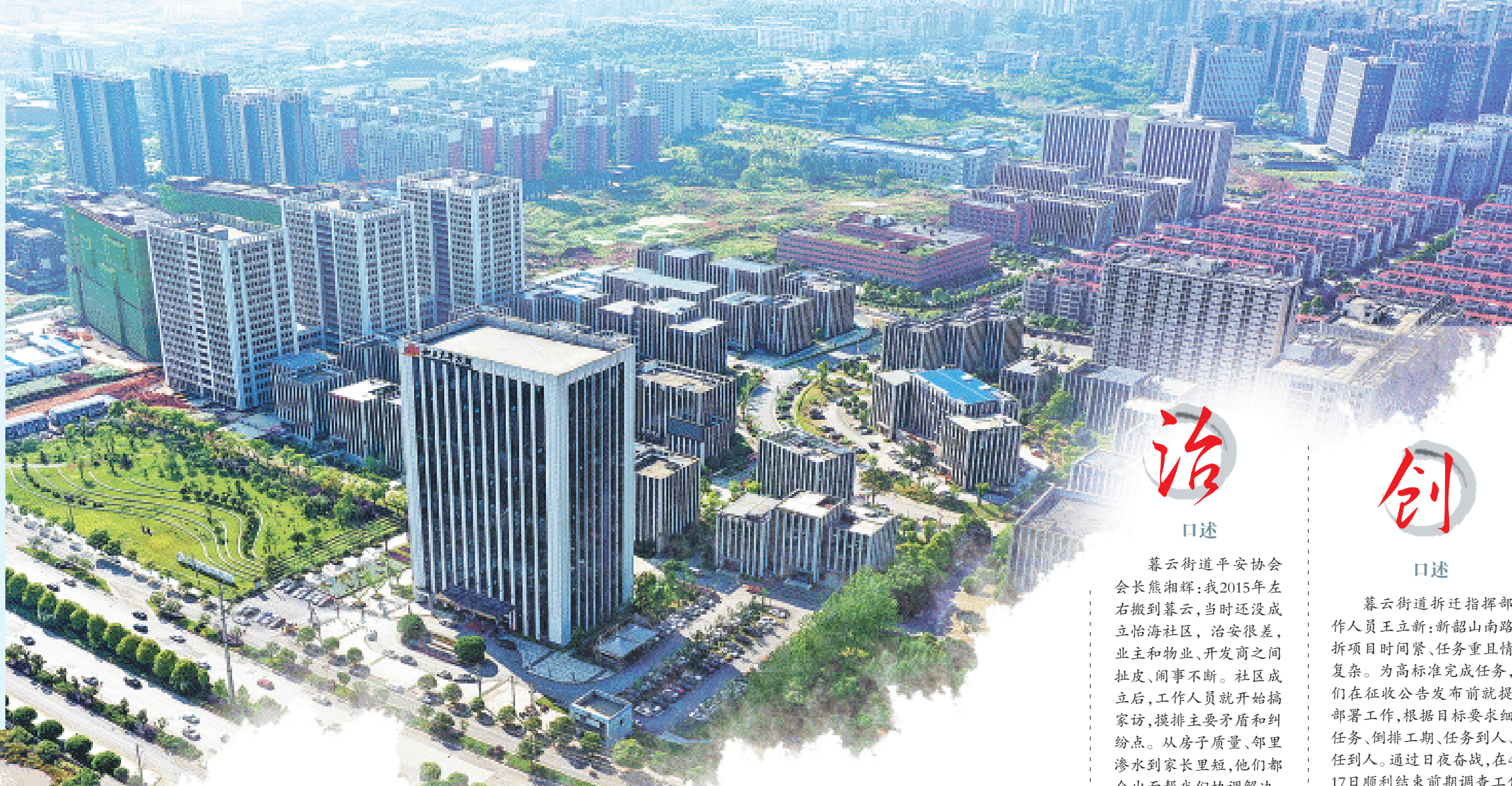
↑ 长沙总部基地落户暮云片区，为辖区经济发展提供强大动能。均为受访者供图
