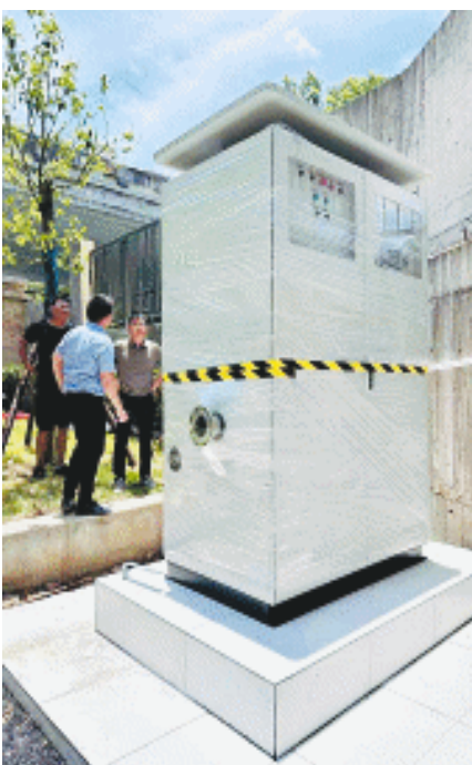
动力北院7号栋新建一体式泵房。 长沙晚报通讯员 杨校 供图
