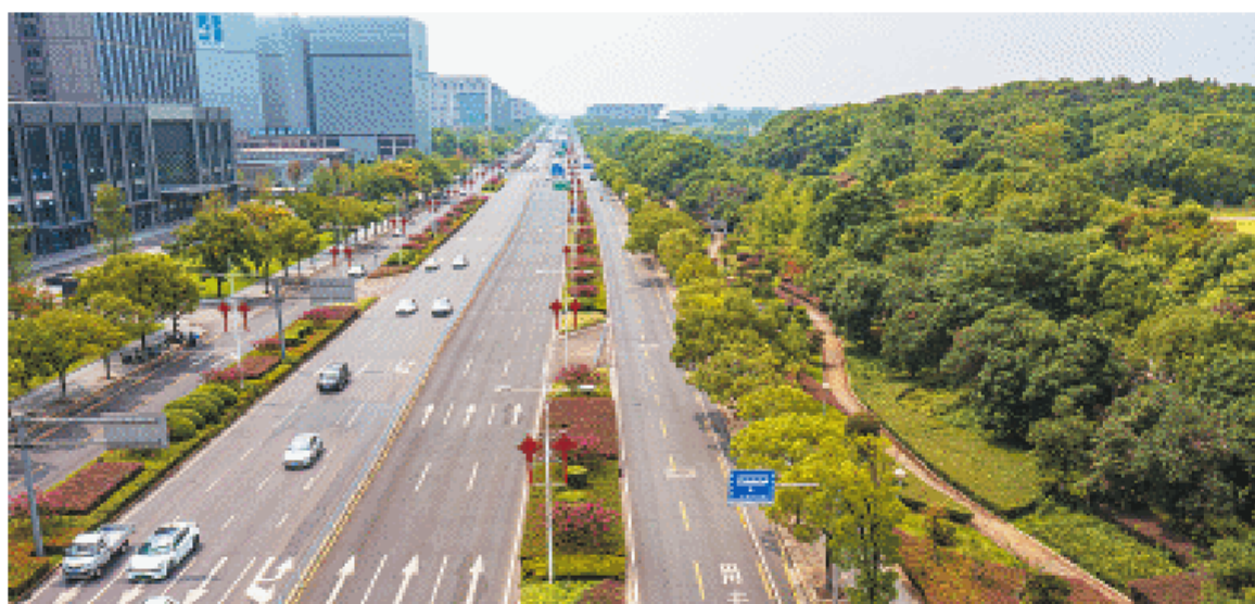
作为长沙重要的交通“动脉”，芙蓉路路面立面干净整洁清爽。
