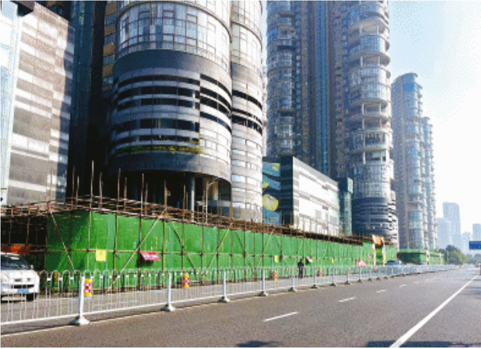
隐患整改过程中,建筑物外墙砖及抹灰层全部剔除。长沙晚报通讯员 李文 供图
