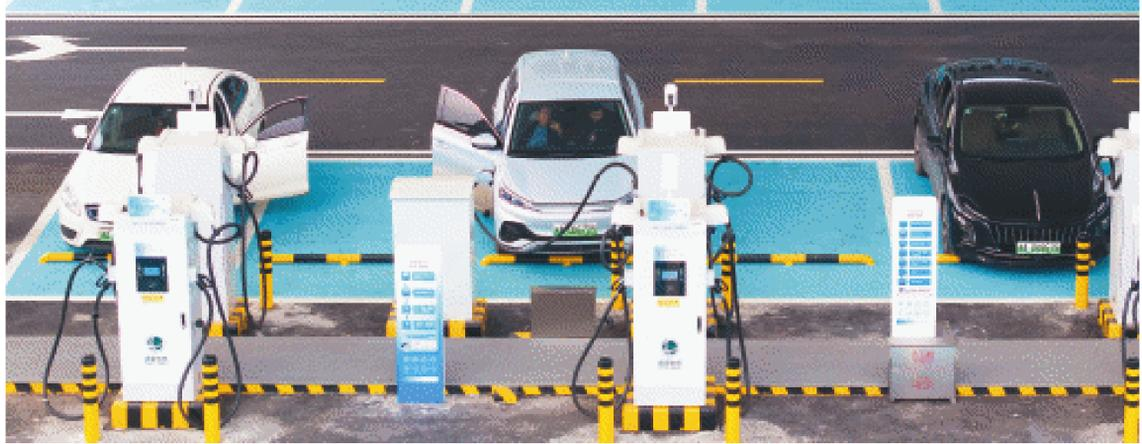
架梨充电站应用液冷超级充电、分体式和一体式快充、光储超充检一体等技术，可同时为40辆电动汽车提供充电服务。长沙晚报全媒体记者 邹麟 摄
