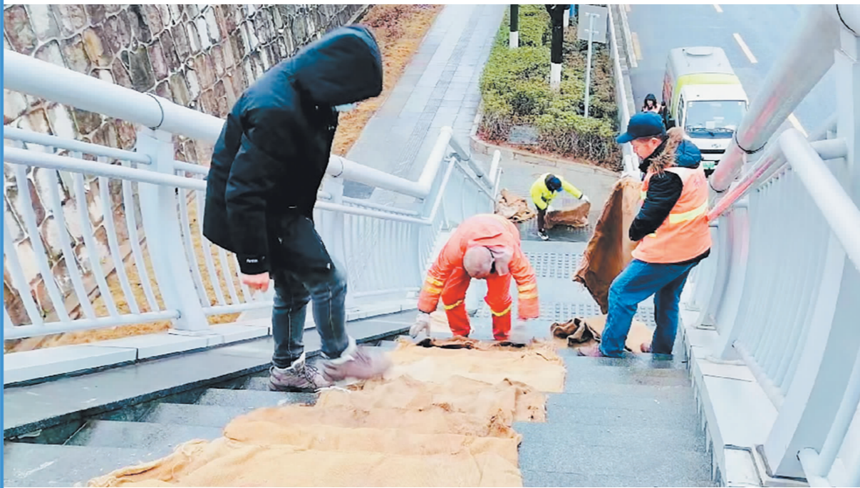
环卫工作人员在给青竹湖大道上的人行天桥“盖毯子”。截至1月20日17时，开福区辖内的14座人行天桥和23条地下通道全部完成2000余个麻袋铺设，以防路面结冰引发事故。长沙晚报通讯员 虞质叶 供图
