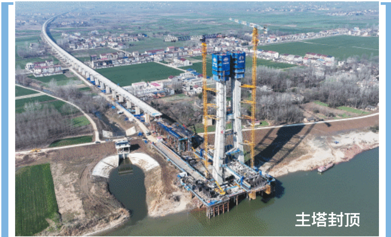
1月24日拍摄的正在进行封顶混凝土浇筑作业的主塔(无人照照片)。当日,由中铁十一局集团承建的沪渝蓉高铁武宜段钟祥汉江特大桥317号主塔顺利封顶。沪渝蓉高铁是我国“八纵八横”高铁网沿江高铁通道的重要组成部分。钟祥汉江特大桥横跨汉江,是沪渝蓉高铁武宜段的关键控制性工程。新华社记者 程敏 摄
