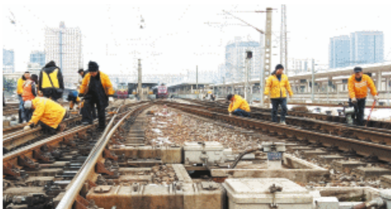
广铁集团长沙电务段长沙信号车间工作人员抢抓“天窗时间”，检修信号设备。长沙晚报通讯员 胡志刚 供图
