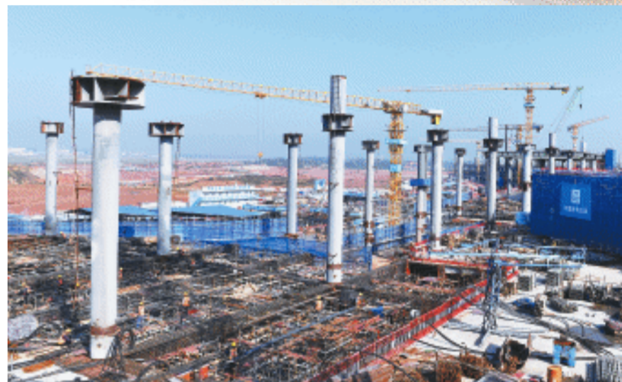
长沙机场T3航站楼项目现场，塔吊林立，车辆穿梭，建设进入主楼主体结构全面封顶冲刺阶段。 王志伟 摄（资料图片）
