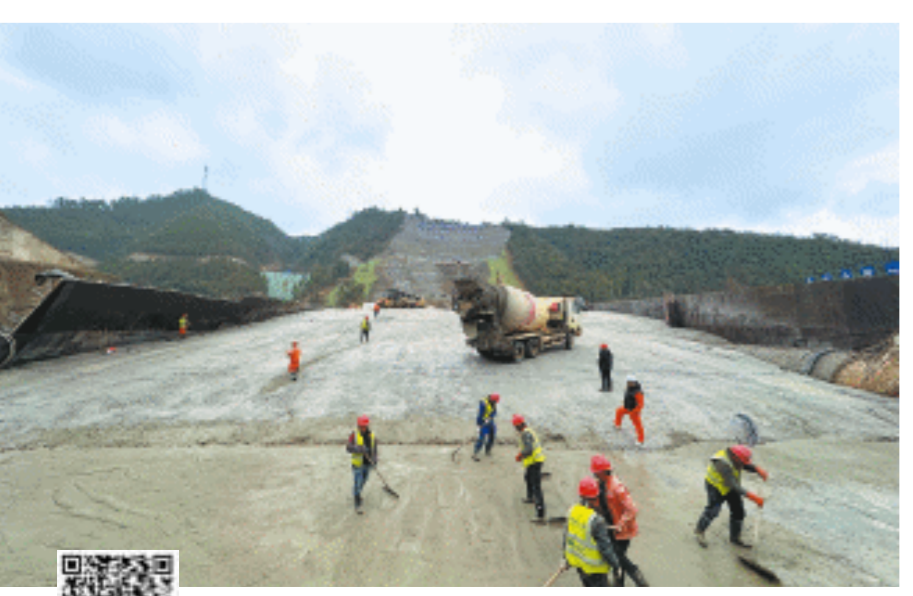
500多名建设者奋战在椒花水库枢纽工程项目一线，大坝混凝土浇筑目前总体进度完成46%。长沙晚报全媒体记者 颜开云 摄
