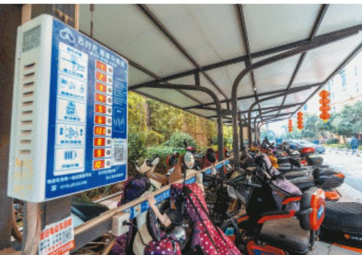
电动自行车停入智能车棚,完成充电后,电源会自动断电。
