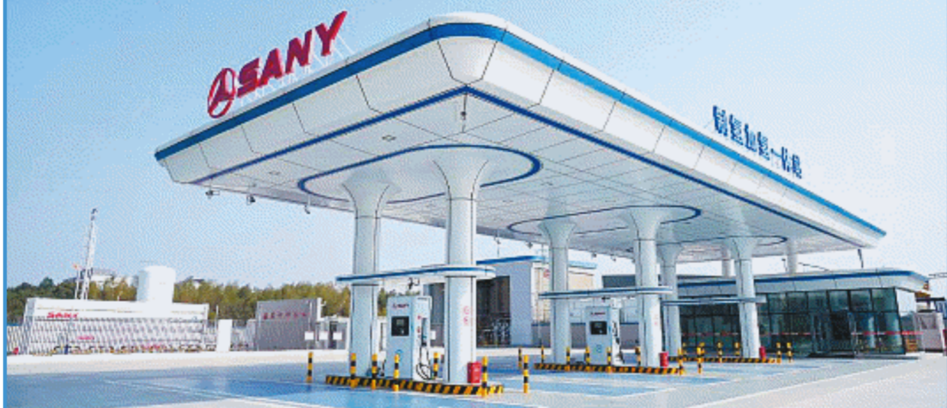
三一绿电制氢加氢一体站总投资超3700万元,占地6300平方米。长沙晚报通讯员 舒展 摄
