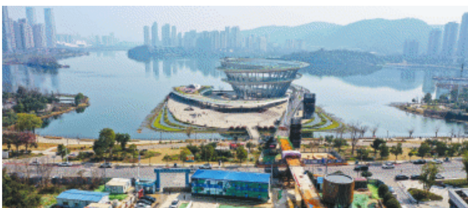
近日,梅溪湖城市岛与超级中轴人行景观桥正式合龙连通。长沙晚报全媒体记者 陈焕明 通讯员 胡翔 摄影报道
