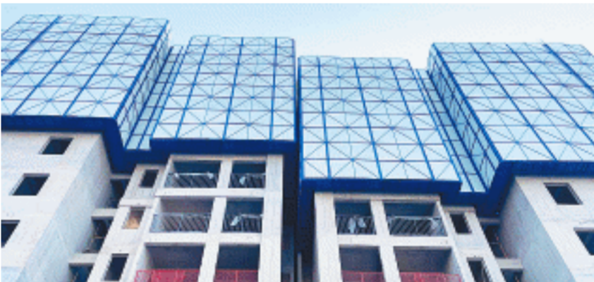
中建信和地产全面推广执行“铝模爬架+全现浇外墙”体系,利用全现浇外墙有效避免了外墙渗漏。
