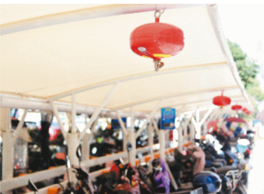
在梅溪鑫苑名家小区,悬挂式干粉灭火装置守护电动车充电棚消防安全。长沙晚报全媒体记者 刘琦 摄
