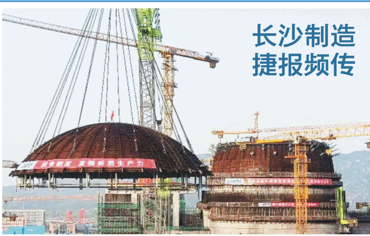
田湾核电8号机组穹顶球冠吊装施工现场。企业供图
