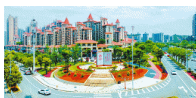
玫瑰园小区消防设施、水泵房、配电房改造项目顺利实施并通过验收。桃花井社区供图
