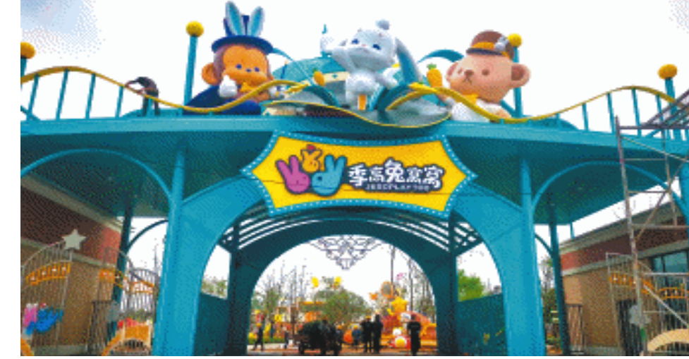
游乐园大门处建筑已经全部完工,内装也基本完成。长沙晚报全媒体记者 颜家文 摄
