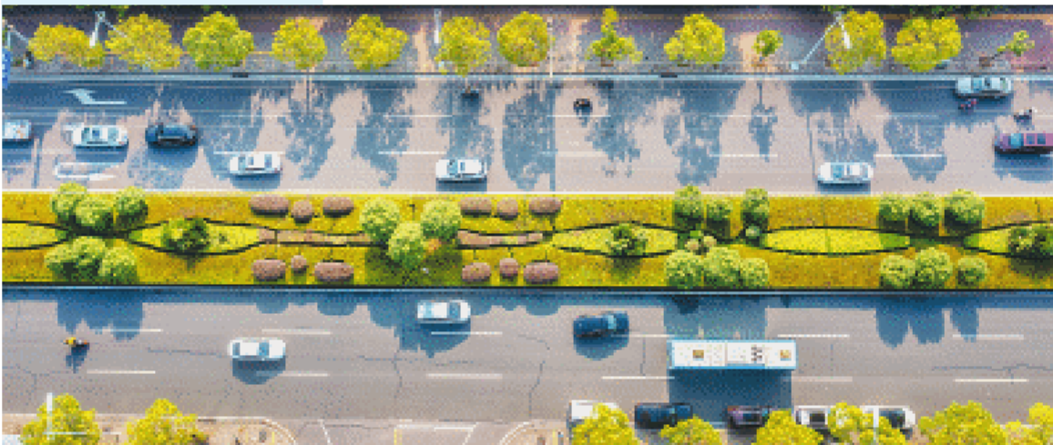
↓今年长沙将开展市政道路整治提质行动,推进重点道路品质提升,进一步打造精美街区。 蔡石蛟 摄
