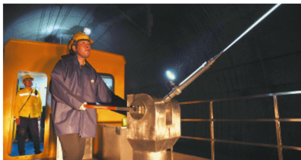
工作人员正在操作绝缘子水冲洗车上的水炮,在隧道内冲洗绝缘子。长沙晚报通讯员 陈梅 贾小林 供图
