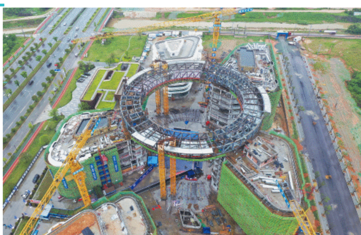
直径74米的“天空之厅”顺利完成吊装,实现精准合龙。长沙晚报全媒体记者 王志伟 摄
