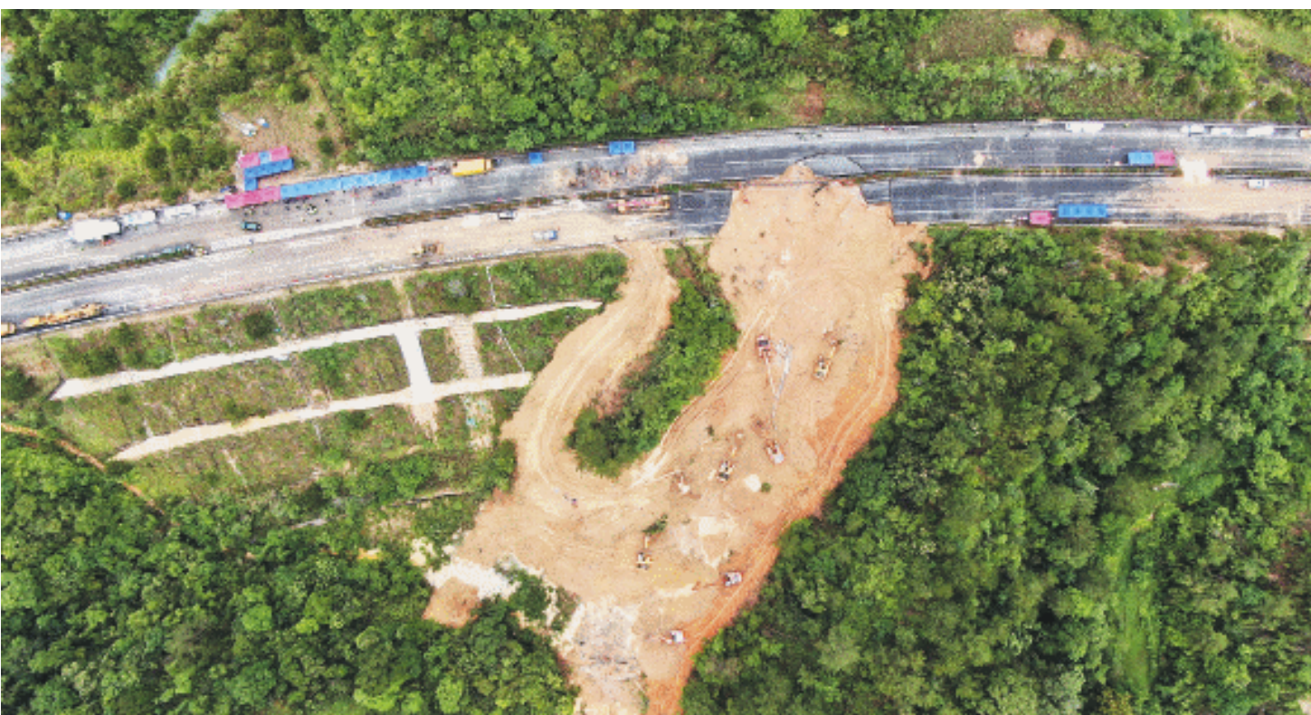
5月2日拍摄的广东梅大高速茶阳路段塌方灾害现场(无人机照片)。新华社记者 王瑞平 摄
