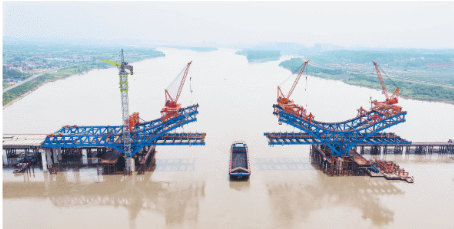
暮坪湘江特大桥正在建设中的主桥上部构造，已初步呈现出“江上展翅”的景象。长沙晚报全媒体记者 黄启晴 摄
