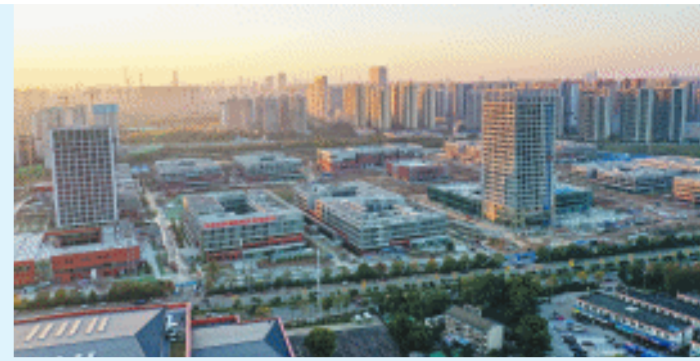
岳麓山实验室集聚区农科院片区从源头减少建筑固体废物排放，实现了绿色文明施工。长沙晚报全媒体记者 王志伟 摄
