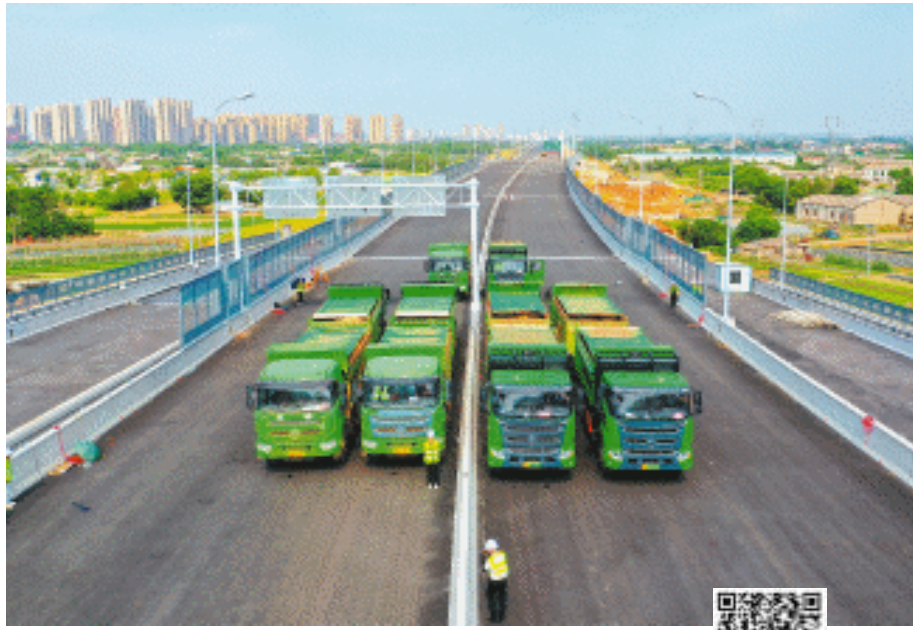
16日下午,湘府东路(浏阳河—黄兴大道)项目进行桥梁荷载试验。 长沙晚报全媒体记者 黄启晴 摄
