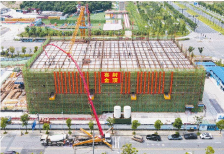
5月16日，梅溪湖D区能源站及金菊路停车场项目顺利封顶。受访者供图
