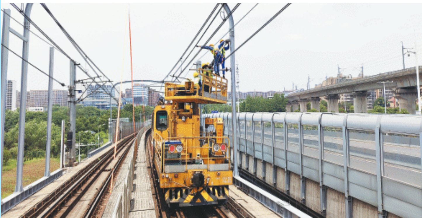
3天里,检修人员三班轮换,24小时施工作业不停歇。长沙晚报通讯员 蔡晨供图
