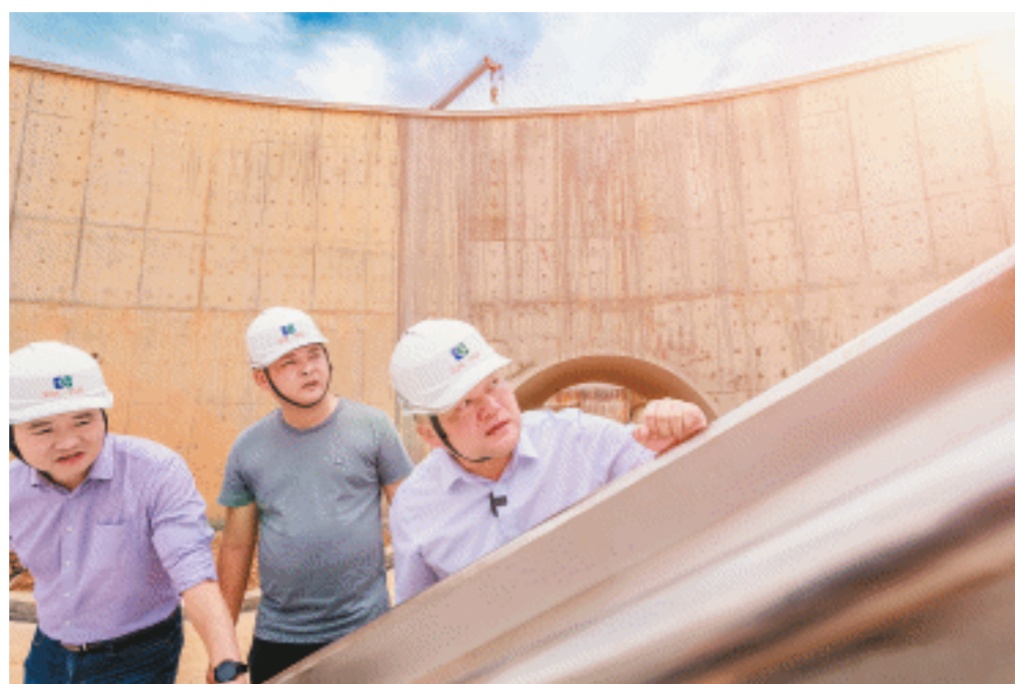
刘灿辉(右一)和团队在大泽湖近自然湿地公园项目施工现场查看。长沙晚报全媒体记者陈飞摄
