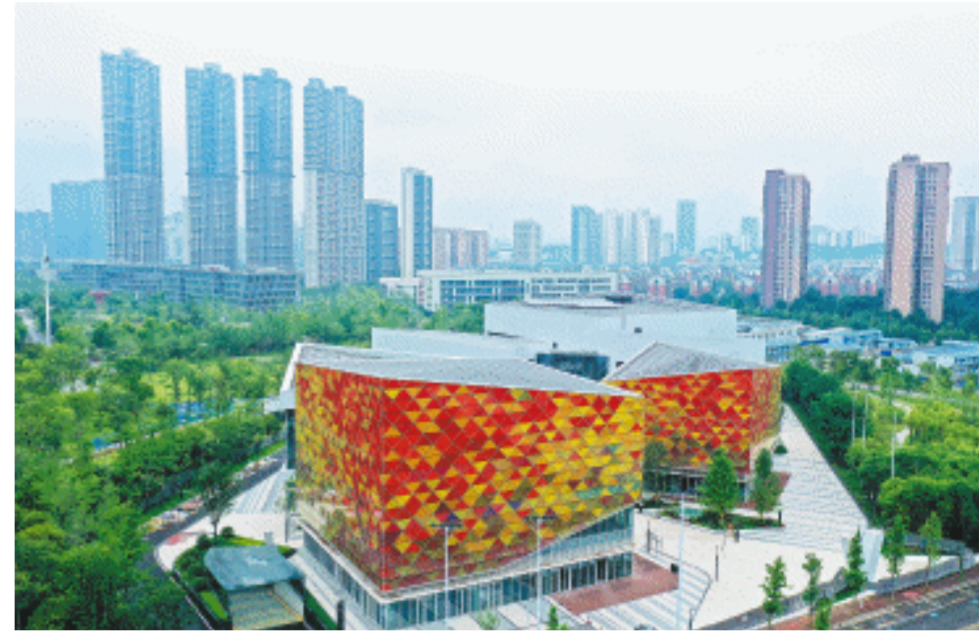
马栏山新媒体中心项目将打造全国领先的媒体融合新地标。 长沙晚报全媒体记者 王志伟 摄
