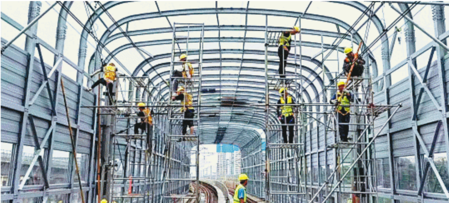
工作人员加班加点,在地铁1号线相关区段开展全封闭式声屏障加装施工,提前3天完成改造任务。长沙晚报通讯员 马在龙 供图
