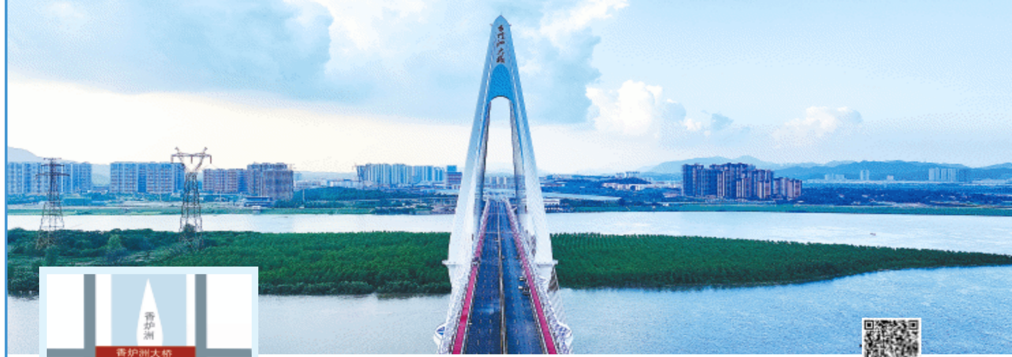
香炉洲大桥项目总投资27.1亿元，主线长3.2千米，匝道长3.8千米，双向6车道。长沙晚报全媒体记者 邹麟 摄
