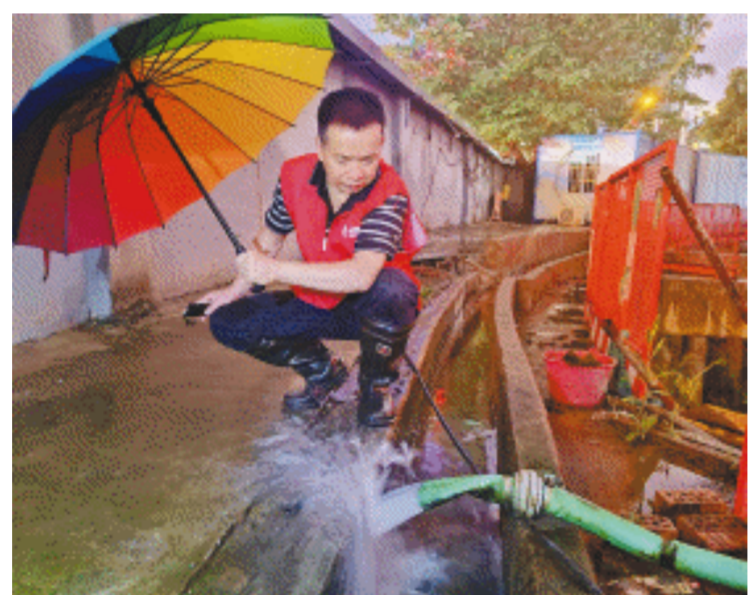
胡志新在查看排水情况。长沙晚报全媒体记者 李卓 摄
