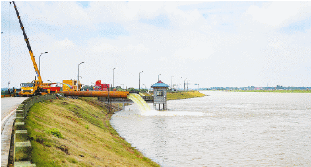
临时架设的水泵正马力全开,将团头湖库容排向乔江。长沙晚报全媒体记者 郭雨滴 摄
