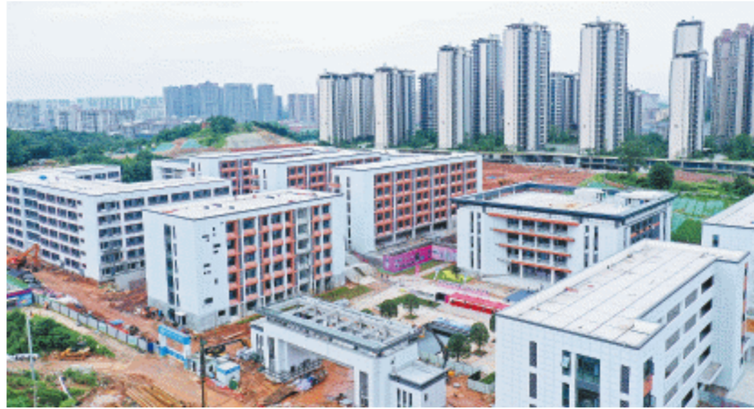
长沙市第十一中学拓址新建项目已进入收尾阶段，预计8月竣工交付。长沙晚报全媒体记者 王志伟 摄
