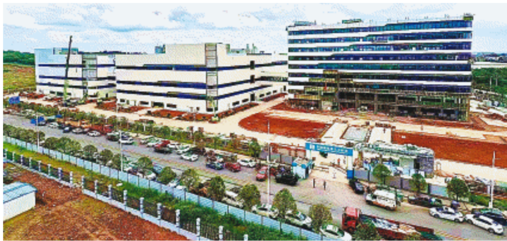
华实半导体新材料研发及测试生产基地一期已完成主体封顶。
