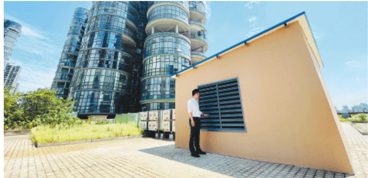
二次净化的管道直达商场楼顶“绿岛”小屋，在屋内再进行终端降噪、吸味处理。
